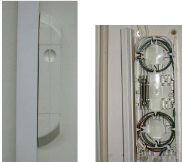
Figure 8 : point de branchement optique : PB Be-Box Acome
