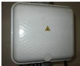
Figure 6 : Point de Branchement Optique, 3M Intérieur-extérieur
